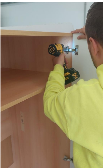
Az oldalelemeknél nincs előre kifúrva a zsanér helye, így ezután óvatosan kell eljárunk. A zsanérral felszerelt ajtókat odaállítjuk a szekrényhez és a kis csavar segítségével erős nyomással rögzítjük. Trükk: Az ajtót kicsit emeljük meg egy kartonlappal, hogy nyitáskor ne érjen le. Később a zsanér állíthatóságának segítségével még tudjuk állítani az ajtók magasságát, dőlését.
