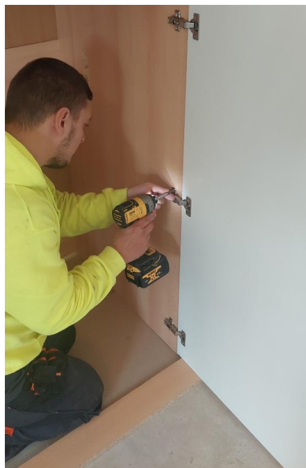
Az oldalelemeknél nincs előre kifúrva a zsanér helye, így ezután óvatosan kell eljárunk. A zsanérral felszerelt ajtókat odaállítjuk a szekrényhez és a kis csavar segítségével erős nyomással rögzítjük. Trükk: Az ajtót kicsit emeljük meg egy kartonlappal, hogy nyitáskor ne érjen le. Később a zsanér állíthatóságának segítségével még tudjuk állítani az ajtók magasságát, dőlését.
